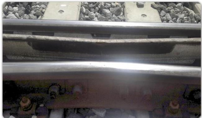
Износ, который создается внутри головки рельса, может привести к подальшим проблемам.
