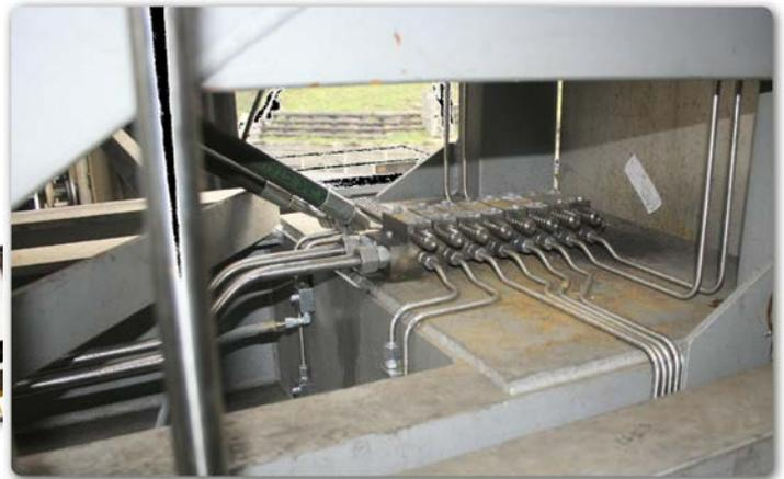
Vannes de gaz sur les fours à coke. Section à 32 points
