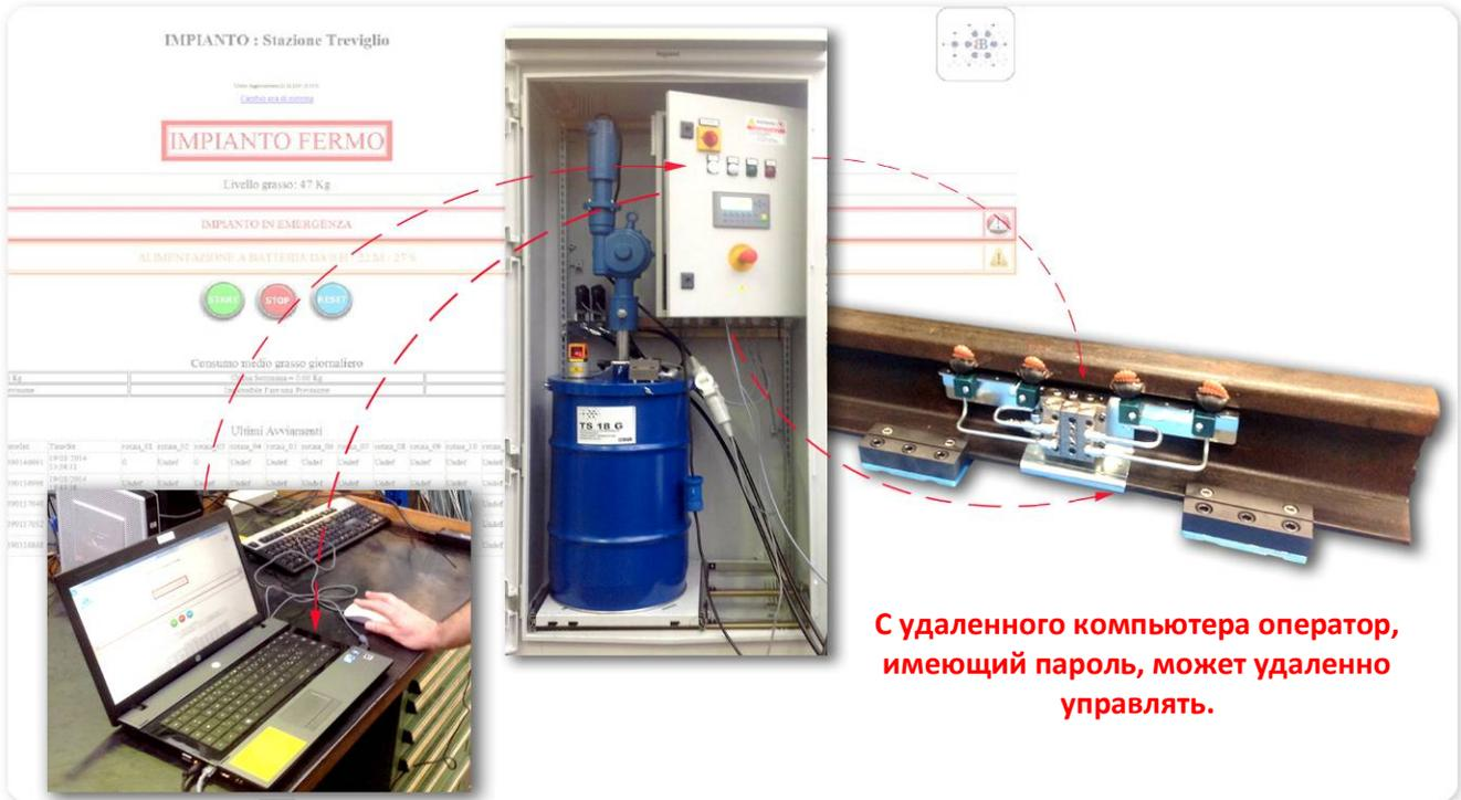
Система для смазки рельсов снабжена многочисленными функциями, кратко перечисленными ниже:
