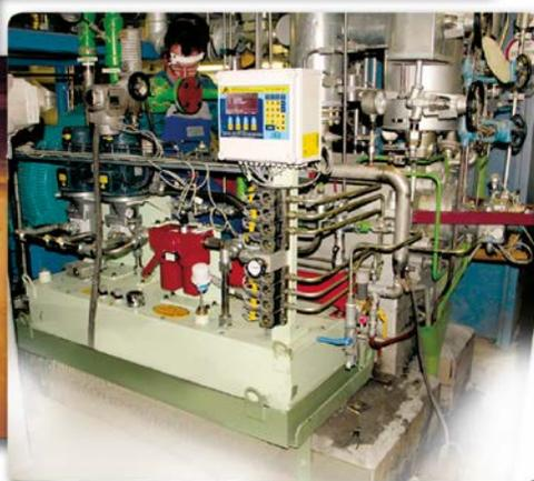
Grâce au **Flowmaster** et à la technologie **Fact 2000** DropsA, il a été possible de concevoir un système de circulation d'huile entièrement automatique et **AUTO-AJUSTABLE**. Ce système régule le débit indépendamment de la température et de la viscosité et garantit que la quantité exacte de lubrifiant est appliquée sur les roulements.
