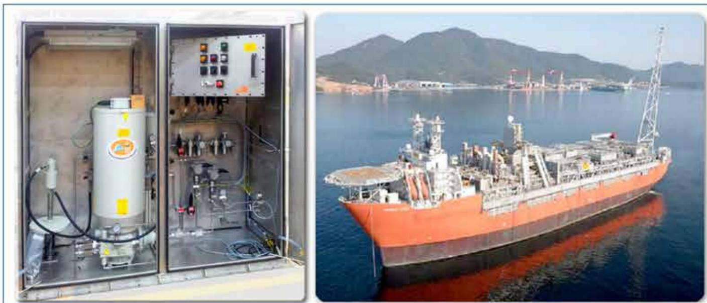
L'utilizzo di sistemi di lubrificazione è indispensabile per il corretto funzionamento delle macchine ancor di più quando queste lavorano in condizioni ambientali difficili come quelle del Offshore. L'installazione di un sistema di lubrificazione automatico consente di ridurre i fermi macchina, controllare il consumo di lubrificante e aumentare la vita di cuscinetti, catene e ingranaggi.
