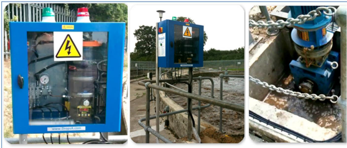
L'utilizzo dei sistemi di lubrificazione è indispensabile per il corretto funzionamento delle macchine ancor di più quando queste lavorano in condizioni ambientali difficili come quelle del settore energetico. L'installazione di un sistema di lubrificazione automatica consente di ridurre i fermi macchina, controllare il consumo di lubrificante e aumentare la vita di cuscinetti, catene e ingranaggi.
